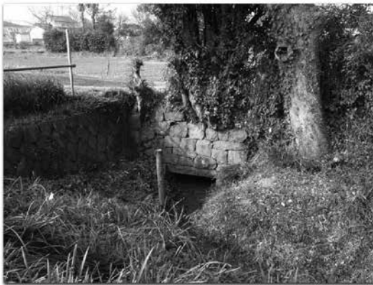
写真 22 旧古川への排水口（高原水車場）
