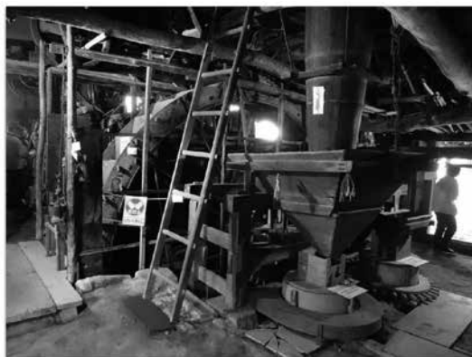
写真 17 昇降機（右斜め上）と大樋（挽き臼の上の筒状装置）
