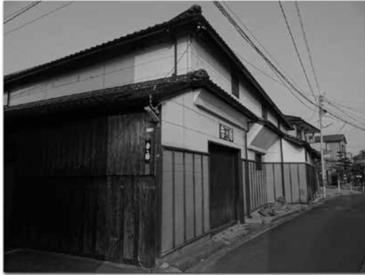
写真 29 神崎屋酢醸造施設（仏生山町）
