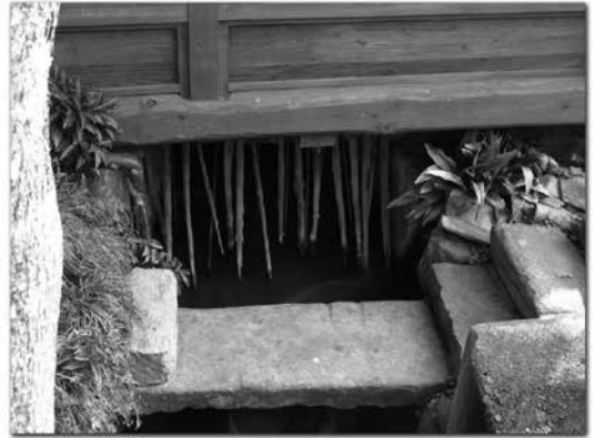
写真 21 水車小屋への導水口（高原水車場）
