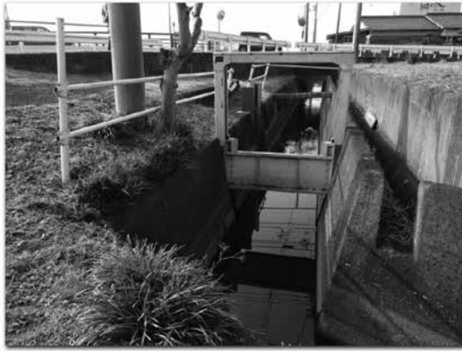
写真 24 用水路、水門（六条町）
