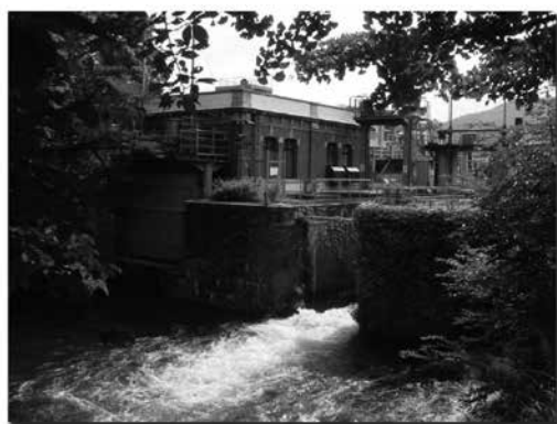
写真8 夷川発電所放水路（京都市）
