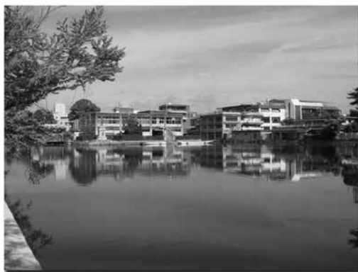
写真 10 夷川発電所貯水池（京都市）
