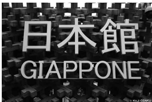
写真 1 日本館の外壁
