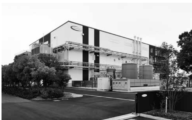
新・岡山第一工場
