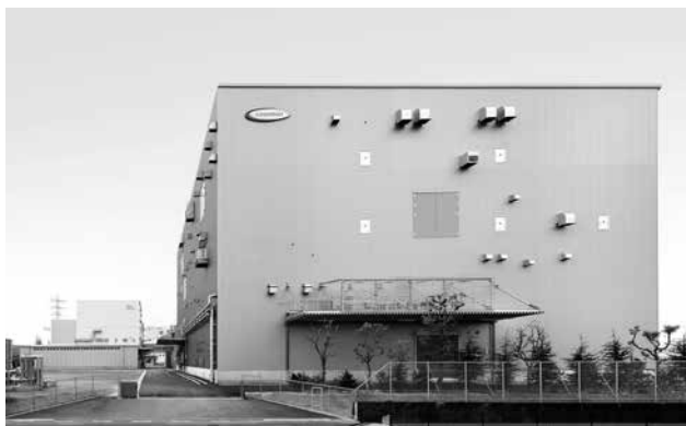
岡山機能糖質工場 S 棟
