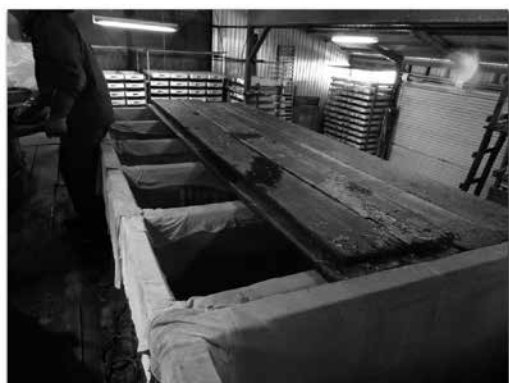
写真 17 上フネと 濾布を取り付け、汲み上げ準備ができた濾過槽
