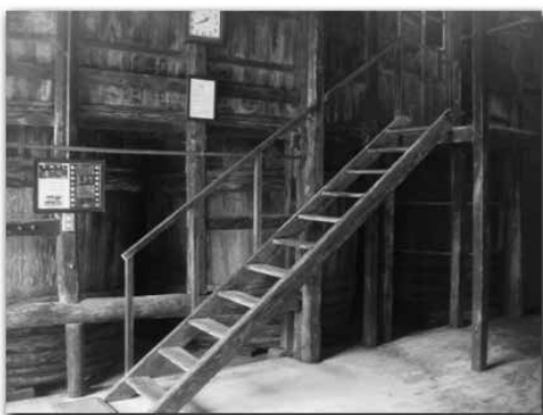
写真9 諸味蔵入り口の階段，たたき部分は以前压榨室
