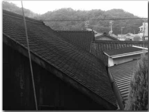
写真 16 手前東蔵，奥西蔵，正面「宮山」を越えると内海湾
