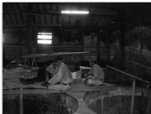
写真 20 修繕中の諸味蔵（腰板を張る前）
