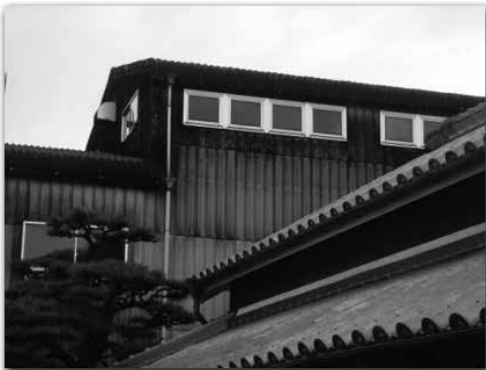
写真 17 新しい諸味蔵（正金醤油），屋根，外壁がうっすら黒く色付いている
