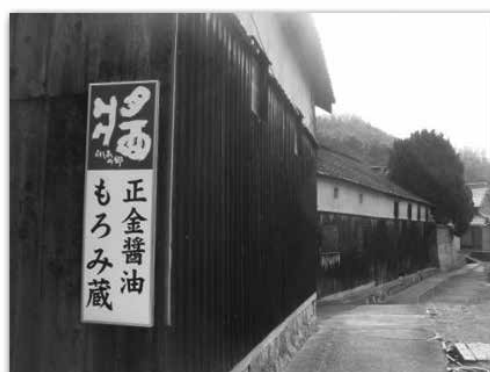
写真 22 正金醤油もろみ蔵として再生(旧山吉醤油)
