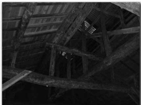
写真 19 屋根の修理（左側は雨漏りがするので天井板を張替）
