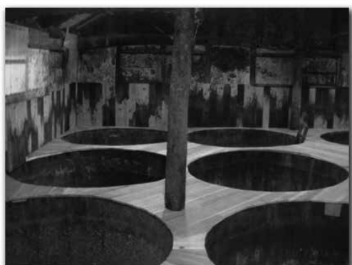
写真 21 修繕後の諸味蔵（腰板、床）
