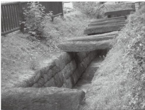
写真1 神田上水で使われていた石樋の移築・復元(東京都水道歴史館)
