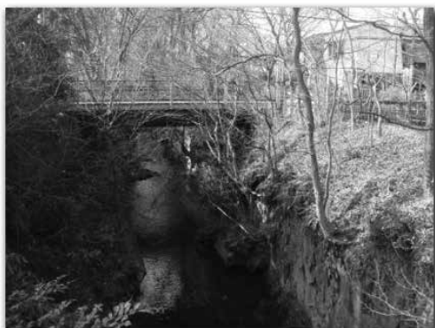
写真 13 玉川上水の素掘り壁面(西武線鷹の台駅付近)
