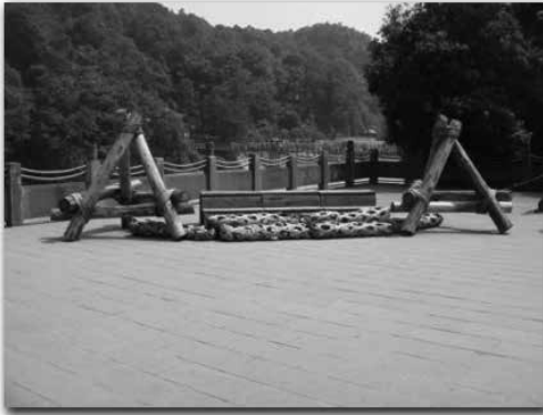
写真6 木組みと蛇籠（都江堰）
