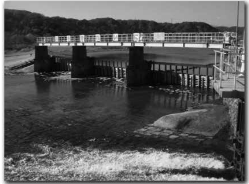
写真7 投渡堰（奥）、手前は小吐口から多摩川に戻る水の流れ
