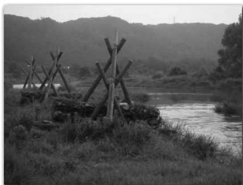
写真4 川岸に並ぶ牛枠（川倉水制）（羽村取水堰）
