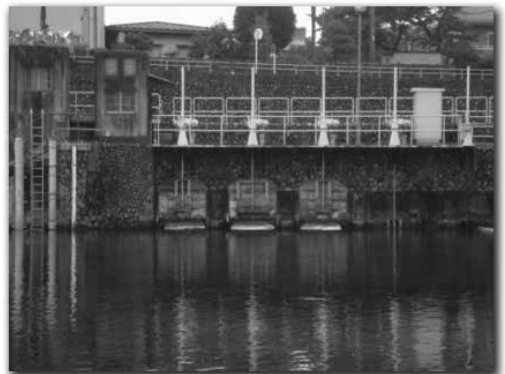
写真8 第一水門（多摩川側）と差蓋（江戸時代は木製、明治になって金属製）
