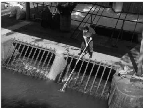
写真 11 現代の芥溜（東京都水道局小平監視所）
