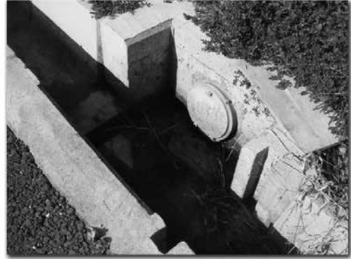
写真 13 田圃の用水路、仕切り板を入れて、流路を変える
