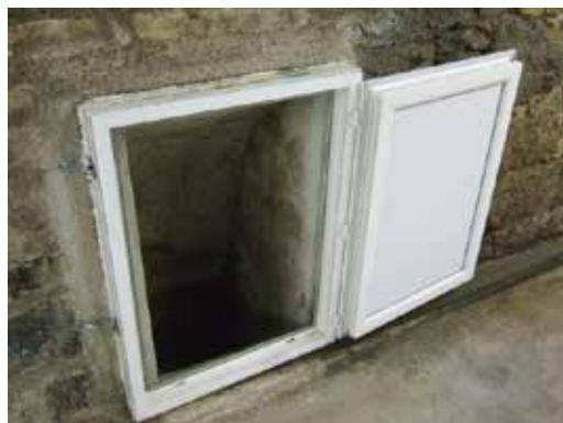
写真 14 カーブの壁に開けられた、洞窟と繋がる通気扉。
